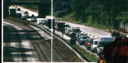
Ein Unterschied wie Tag und Nacht: Auf Autobahnen liegen Baustellen oft tagelang brach (li.), in Frankfurt wird im Akkord gebaggert
