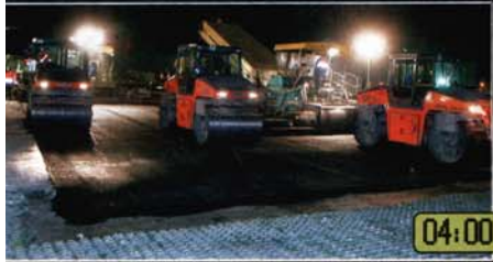
04:00 Walzen im Dreivierteltakt: Schon gegen Morgen wird der Asphalt gewalzt. In zwei Stunden landet das erste Flugzeug
