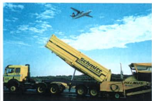
Neue Asphaltdecke für den Köln-Bonner Flughafen: Die Kipper von Schmitt Peterslahr transportierten insgesamt 250 000 t Mischgut.
